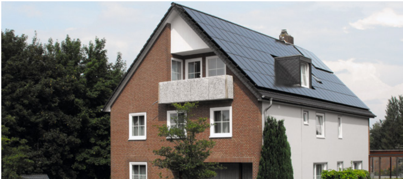
Der Besitzer dieses Wohnhauses in Norddeutschland ist von den hohen Ertragswerten der Solar Frontier CIS-Module begeistert.
