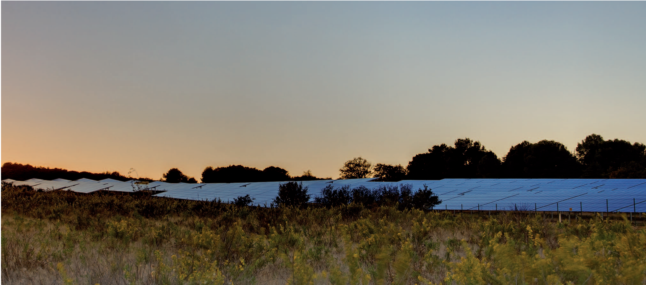
Das Solarkraftwerk in Bessan mit seinen 29.931 Modulen ist die erste auf der CIS-Technologie basierende Freiflächenanlage von Solar Frontier in Frankreich. (Foto: BELECTRIC France)
