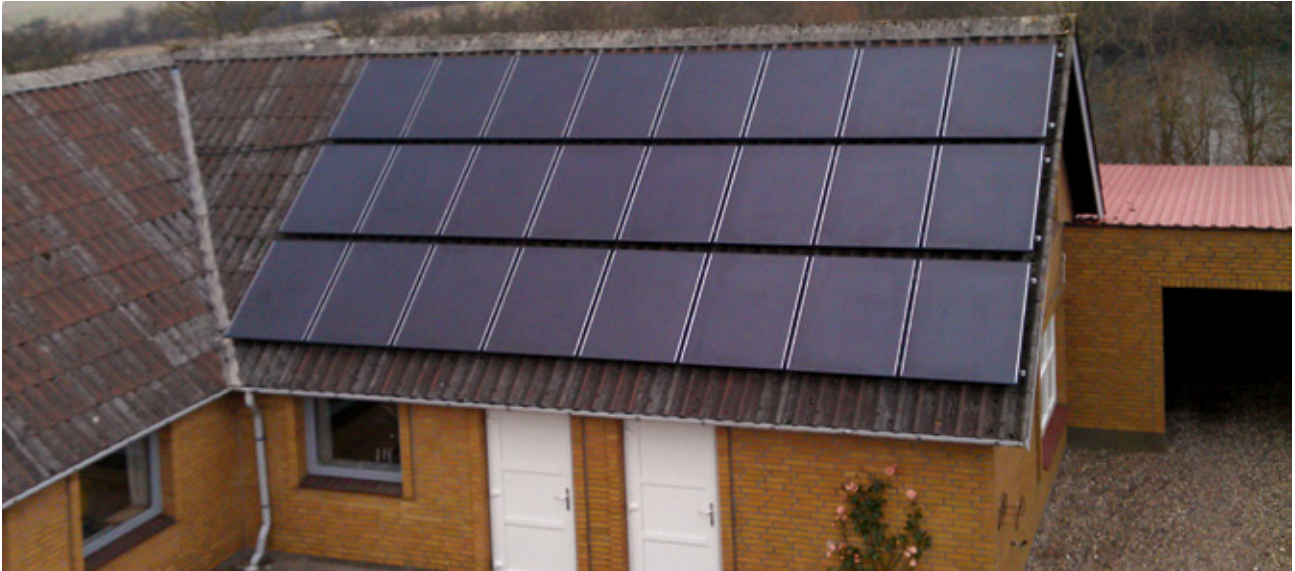
48 Solar Frontier CIS-Module wurden auf dem Ost- und Westdach dieses Hauses in Vissenbjerg installiert. (Bild: FreeEnergy)
