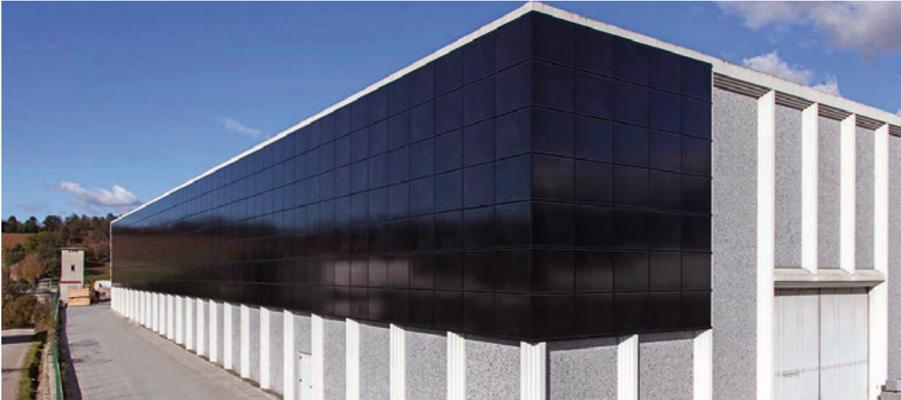
Die schwarzen CIS-Dünnschichtmodule von Solar Frontier machen die Gebäudefassade in Bibbiena zu einem besonderen Blickfang. (Bild: Baraclit)
